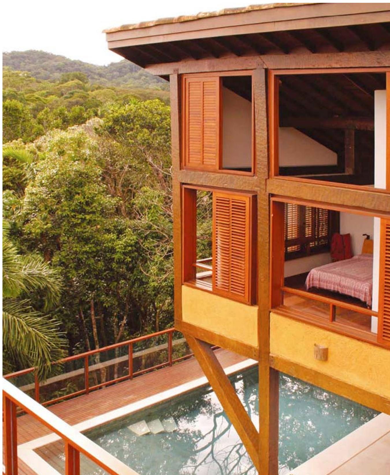
**Do terraço** do pavimento superior observa-se o balanço da estrutura da suíte principal sobre a piscina. os ambientes externos somam 329 m<sup>2</sup> suspensos sobre a estrutura de madeira, que foram montados com deque de jatobá aparelhado. A vista privilegiada é assegurada pelos grandes vãos de 1,90 m de altura
