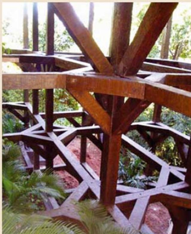
As peças ortogonais foram fixadas umas às outras por sistema de nós com encapsulamento metálico, parafusamento, porcas e arruelas de pressão. Horizontalmente, a malha chega a 4,90 x 4,90 m. As peças foram fixadas sobre a fundação de sapatas, apoiadas sobre o solo firme encontrado sob a cobertura vegetal da mata. Os arquitetos optaram por reforçar com tubulões de concreto os pontos de apoio com maior carga e instabilidade do terreno.
