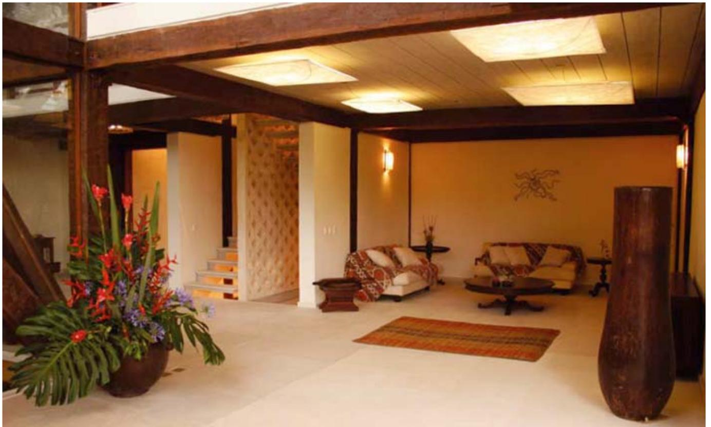
Os acabamentos rústicos e as estruturas de madeira aparente conferem unidade visual à sala de estar. O forro do teto é o fundo das lajes tipo painel. A estrutura pintada apresenta um aspecto de lambri de concreto com frisos em sentido único. O piso foi montado com pedras rústicas (limestone marfim sem polimento) em placas de 60 x 60 cm.
